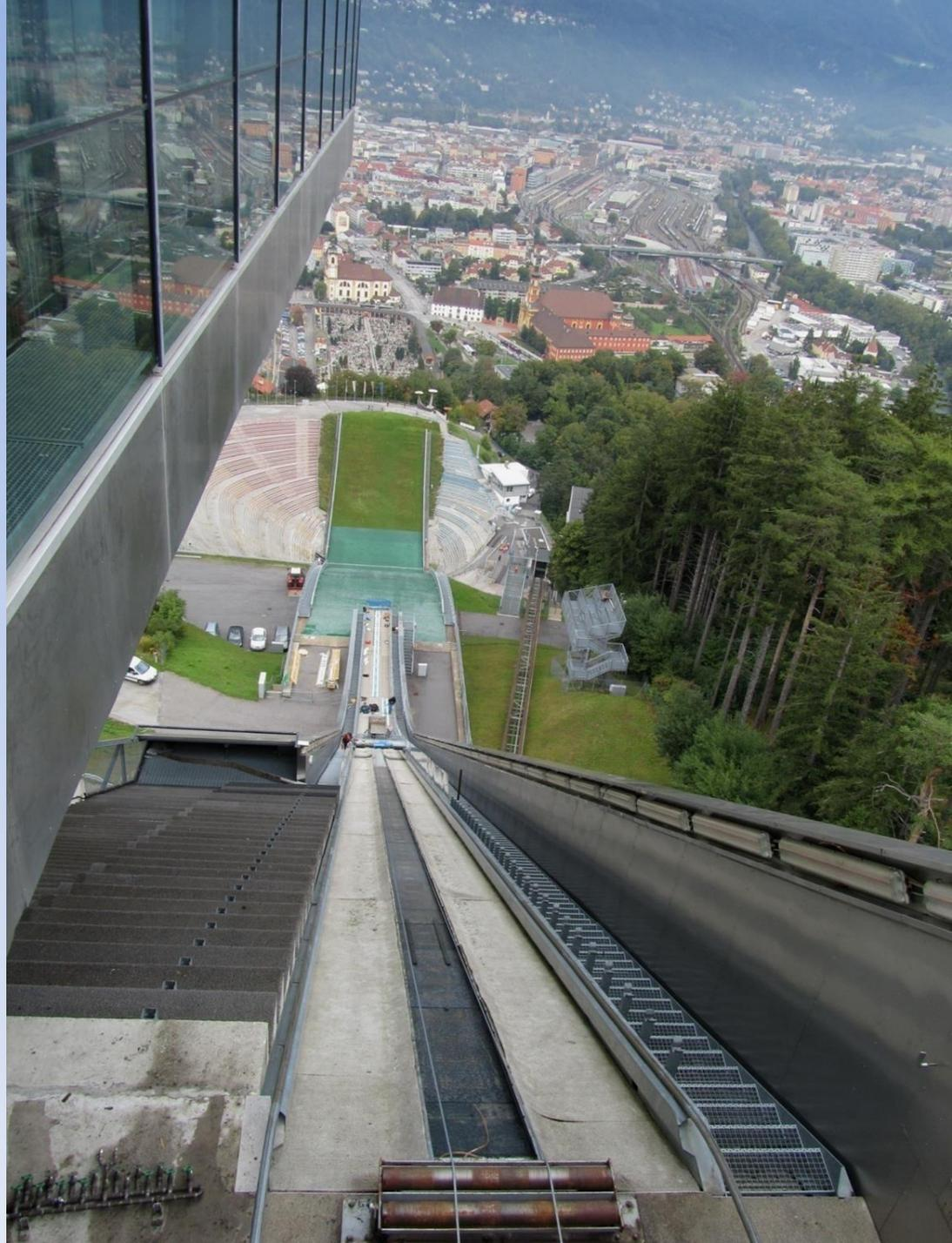
La solución para la construcción del trampolín siguieron los cálculos del ingeniero Christian Aste, sin puntos de soporte. Una viga maestra denominada *Fischbauch*, “vientre de pez”, de 68,5 m de acero y alambre de acero que adquiere una inclinación de hasta 35°, es la destinada a la construcción de la rampa de lanzamiento. El contrafuerte de hormigón de salida del trampolín fue construido imitando la forma de las rodillas de un saltador según el diseño de Franz Fuchslueger.
