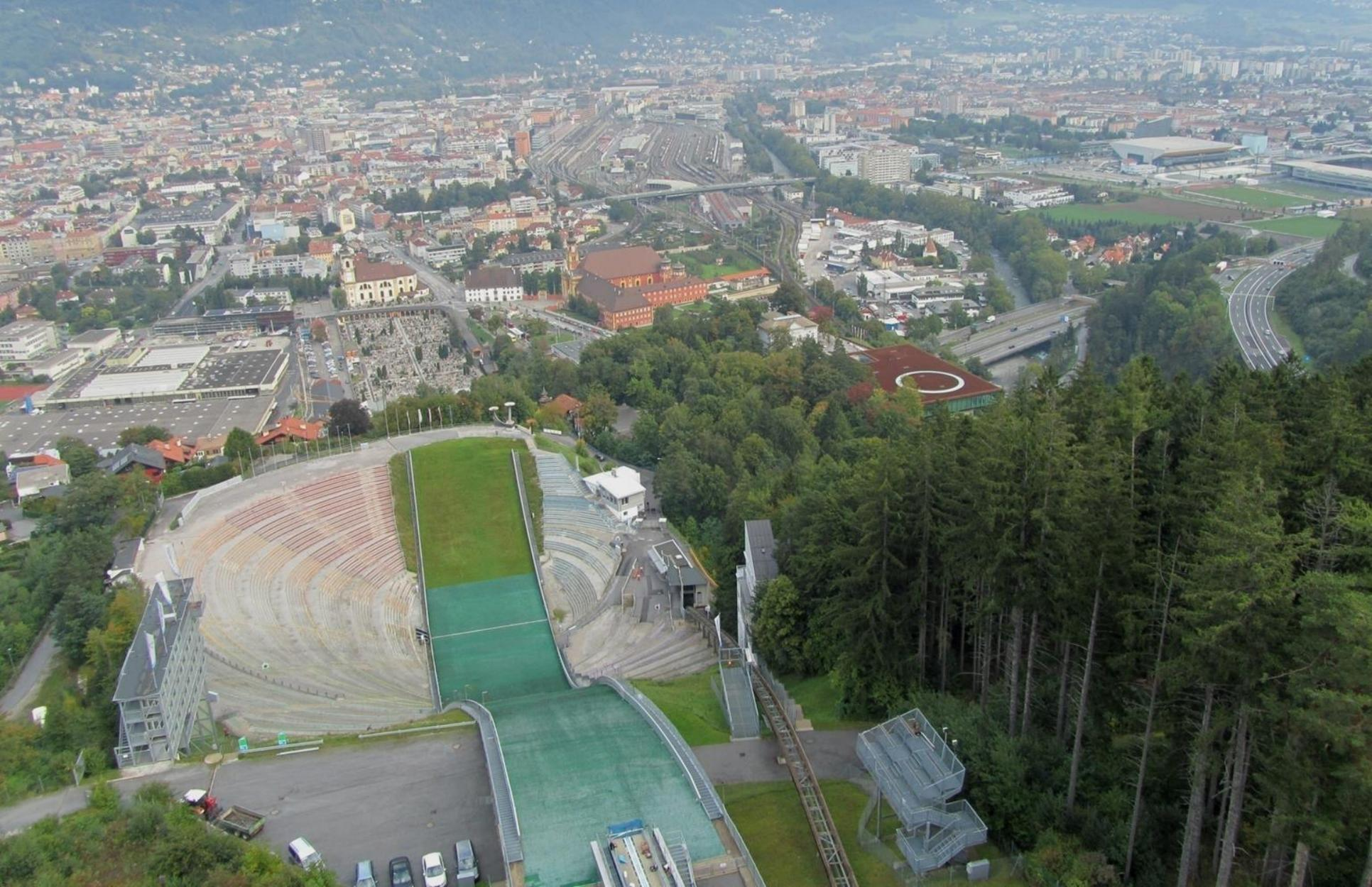
El lanzamiento se realiza en un carril de plástico. Este carril se riega en verano y en invierno se cubre con 30 cm de nieve helada. El lanzamiento es de 98 m de longitud. En un tiempo de 4 segundos después del arranque, el saltador alcanza más de 90 km/h. Los esquís de salto tienen una longitud de hasta 3 m, dependiendo de la talla del atleta, y 11,5 cm de anchura. Un traje especial, calzado de salto, anclaje de seguridad, casco, gafas y guantes completan en equipamiento.
